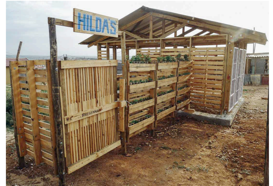
Die fertiggestellte Erweiterung
