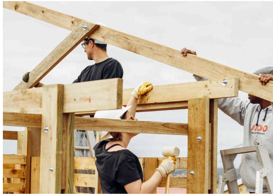
Montage der Dachbinder
