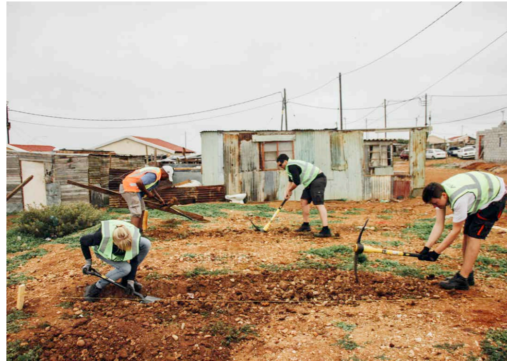
Herstellung der Fundamentgräben
