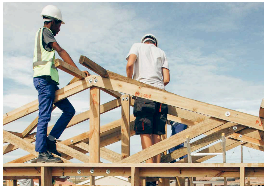
Montage der Dachpfetten
